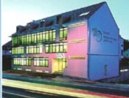
Seit eineinhalb Jahren logiert Soloplan in dem neuen Firmengebäude.
